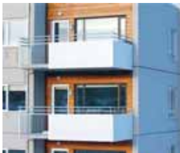
Vinsælt er að hafa hluta svala opnar með stálpílurum, en annan hluta lokað- an fyrir veðri og vindum. MYND/STÁL Í STÁL
